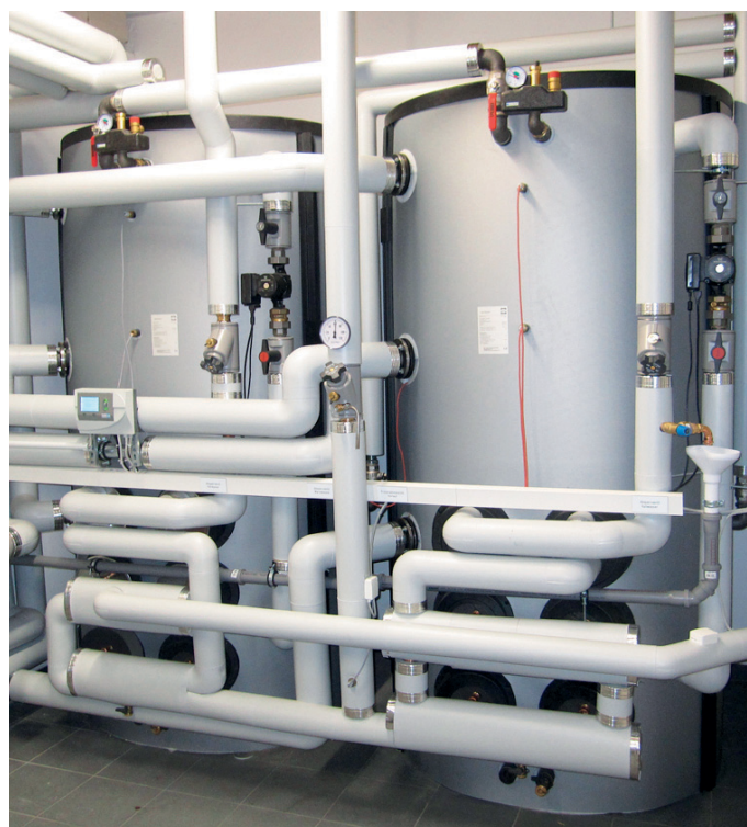
5 – Anlage mit 2 CAPITO Pufferspeicher 2-Zonen-PD 1500.
